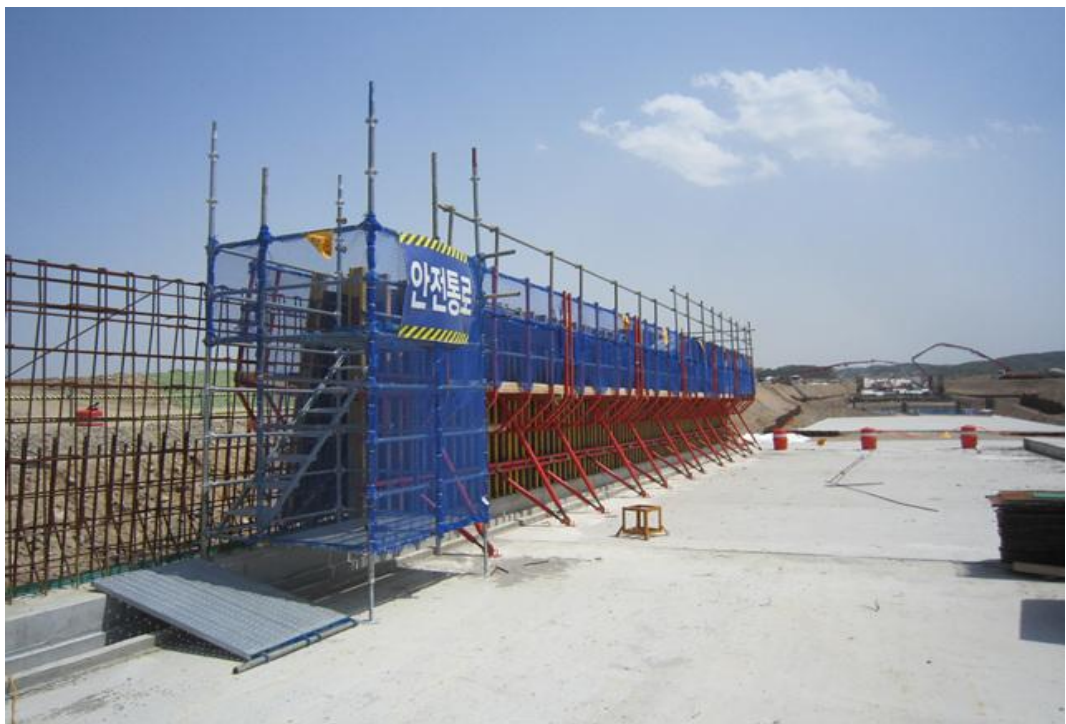
지하차도#2 작업발판 일체형 거푸집 전경
