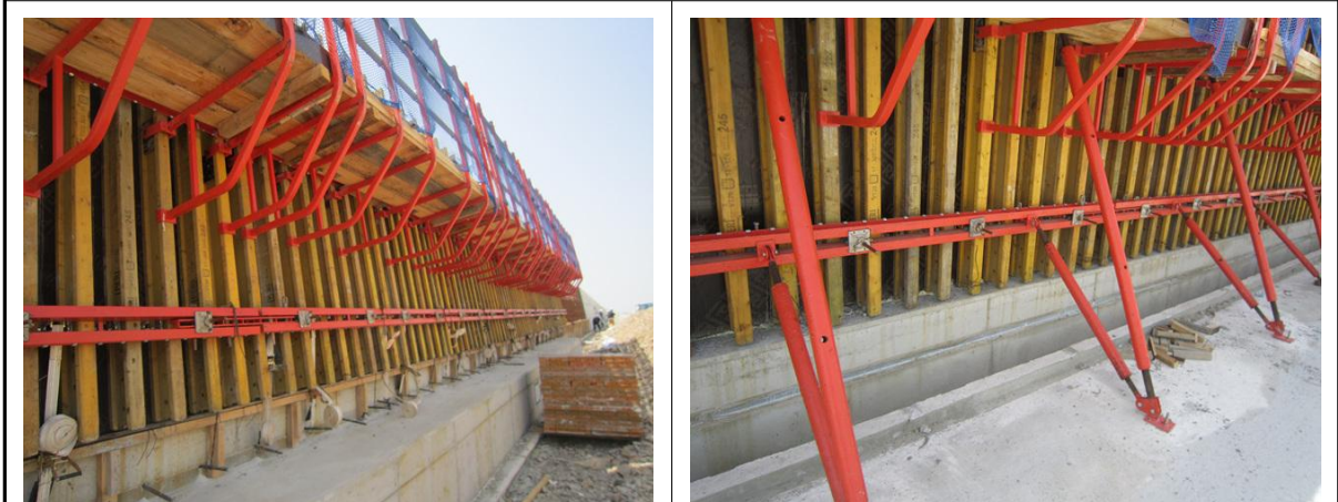
작업발판 일체형 거푸집 설치 상태 현황
