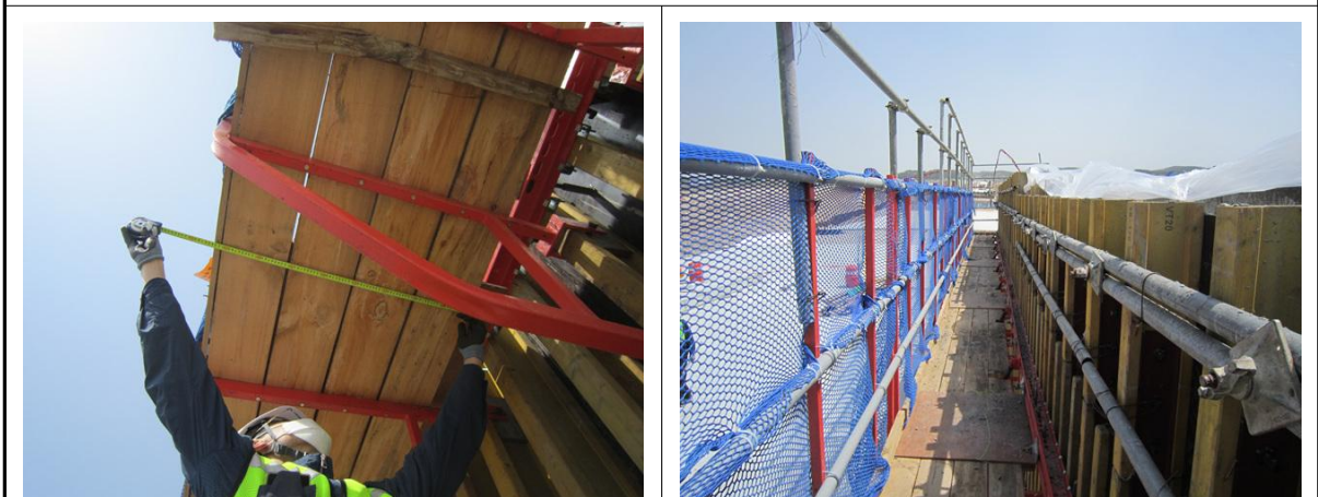
작업발판 일체형 거푸집 설치 상태 현황
