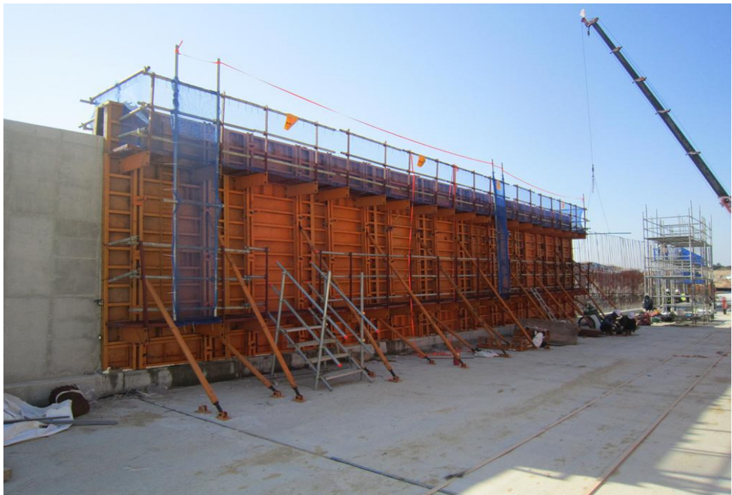
지하차도#1 작업발판 일체형 거푸집 전경
