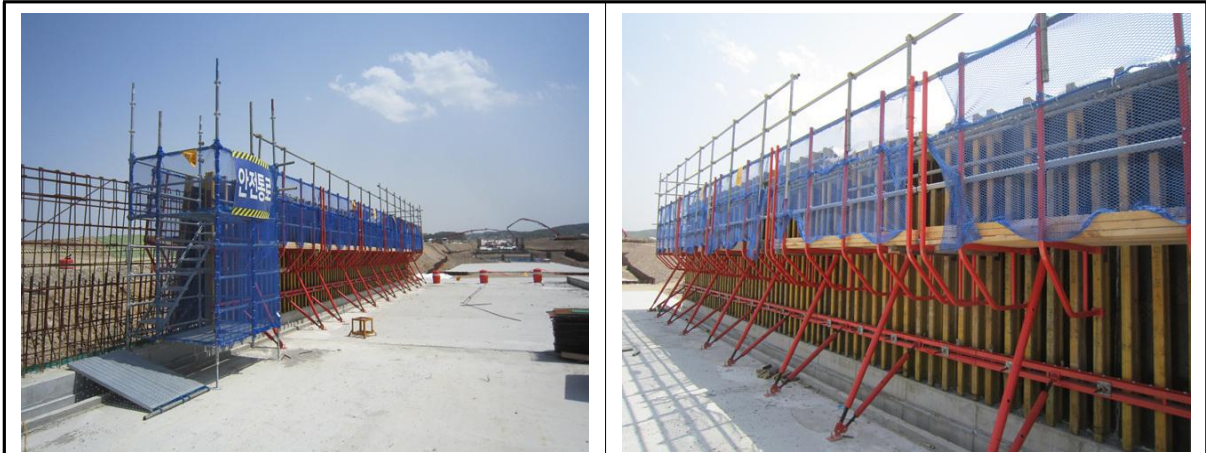
작업발판 일체형 거푸집 설치
